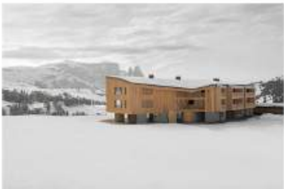
Die Icaro-Hütte in Seiser Alm, Südtirol, MoDusArchitects, um das Gebäude zu renovieren und seine Identität zu erneuern. © S. Buzzi
