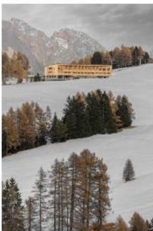
Die großzügige, zweistöckige Loggia integriert sich nahtlos in die bestehende Struktur. https://www.mo-dus.com/
